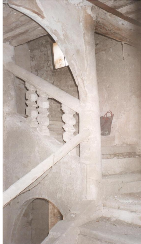
Fig. 22. Les balustres conservés.
