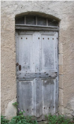
Fig. 17. La porte de la façade nord.
