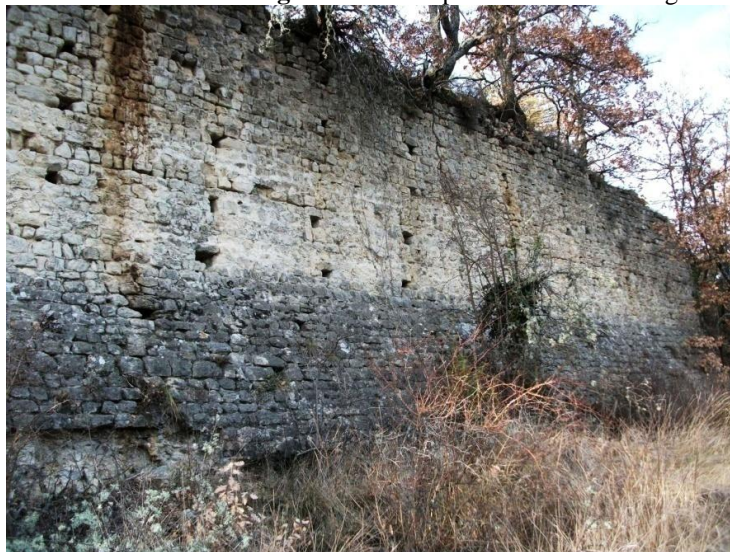
Fig. 10. Le mur d'enceinte et de soutien ; noter les trous de boulins.
