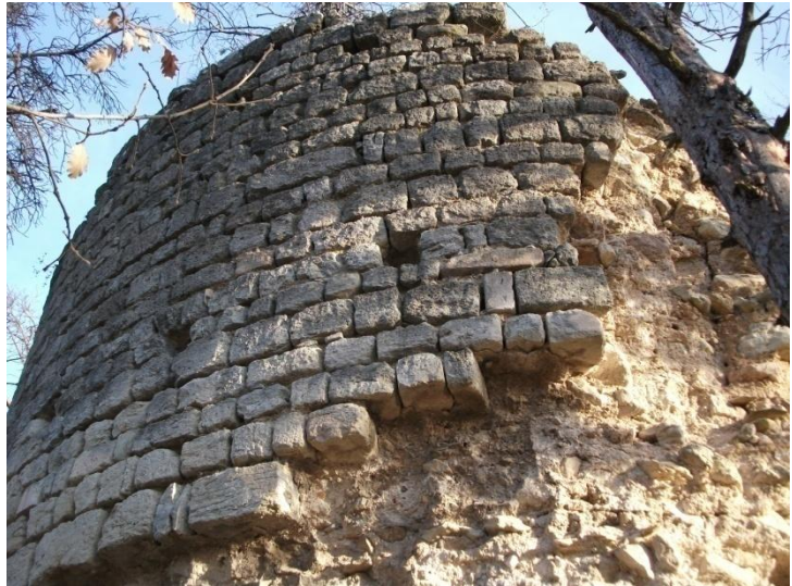
Fig. 9. Détail du parement et du blocage de la tour.
