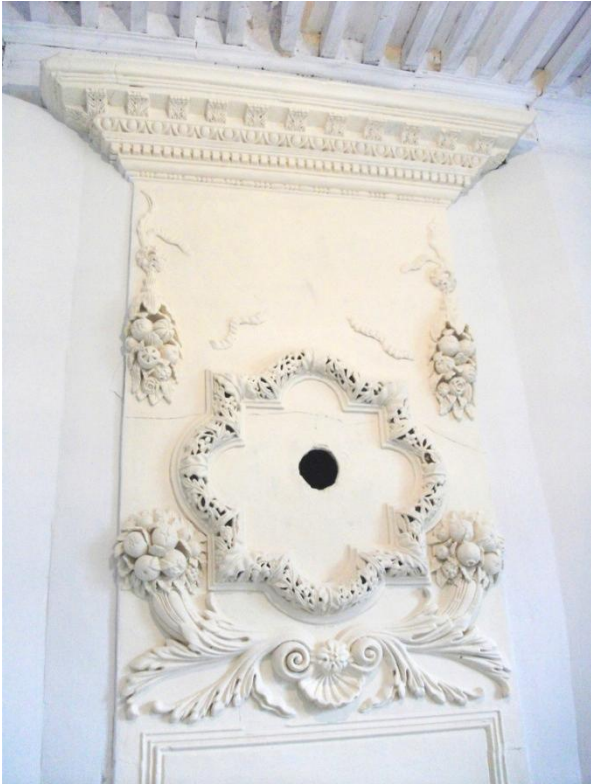
Fig. 15. La cheminée en gypserie de la salle de réception.
