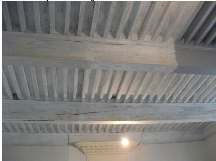
Fig. 18. Plafond à la française et les énormes poutres.
