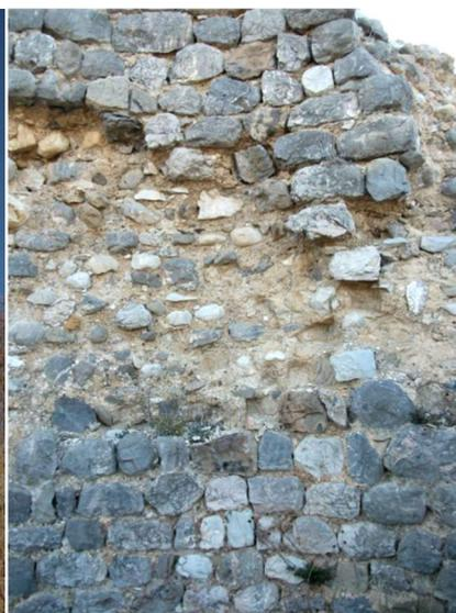
*Fig.2 La tour-donjon : parement externe taluté dépierré. fig.3 Parement intérieur et blocage*
