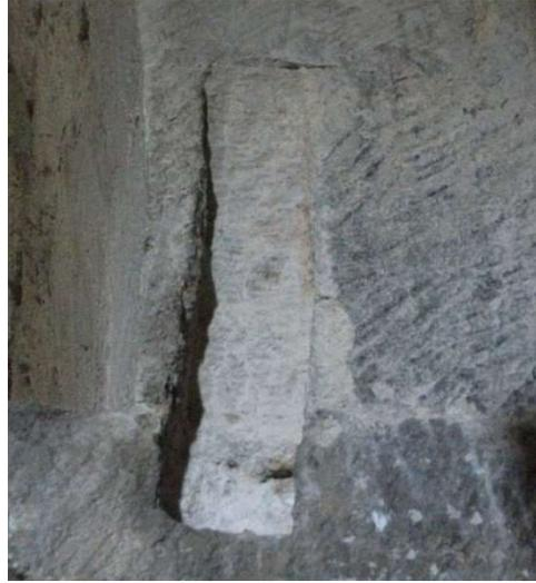
*fig. 23 Trace d'encastrement de barre en vis-à-vis*
