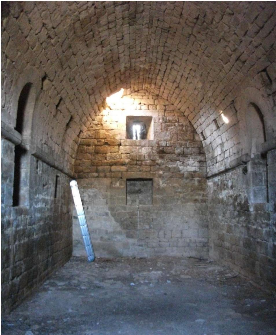
*Fig.17 La salle haute. On y voit deux niches, des trous de boulins et la fente haute pour jour dans la paroi ouest*
