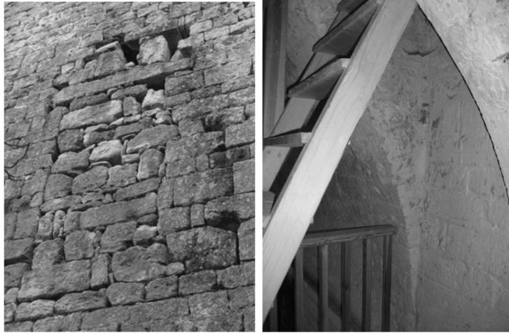
*Fig.31 Détail de la porte haute et de son linteau*      *fig.32 Départ de l'ouverture de la voûte pour trappe*
