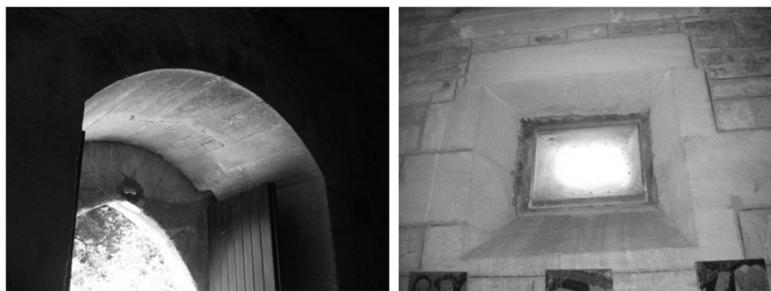
*Fig.34 Arc surbaissé, partie intérieure de entrée basse*      *fig.35 Bouche à feu avec pierres plus récentes*
