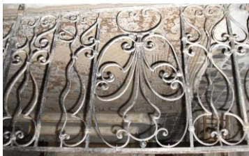
Clôture de chœur en fer forgé.
