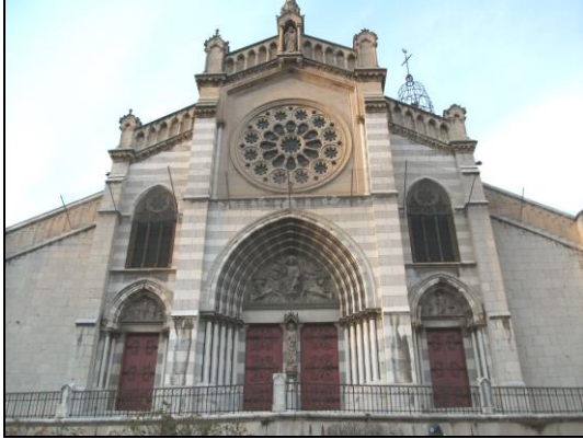
La façade néo-gothique
